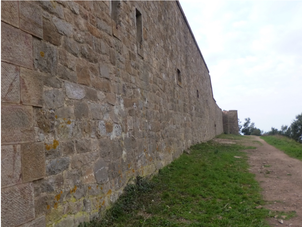
Le mur d'enceinte nord du Fort de la Gavaresse.
